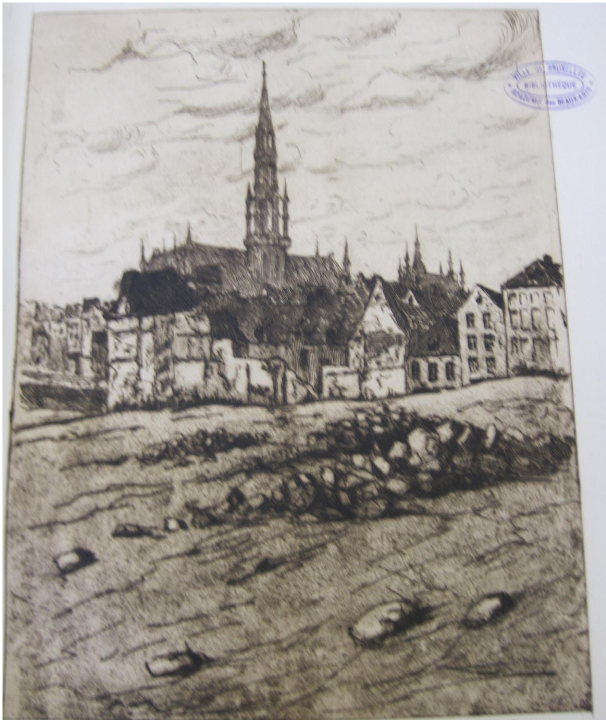
Quartier de la Putterie : 1. LES DÉMOLITIONS.
