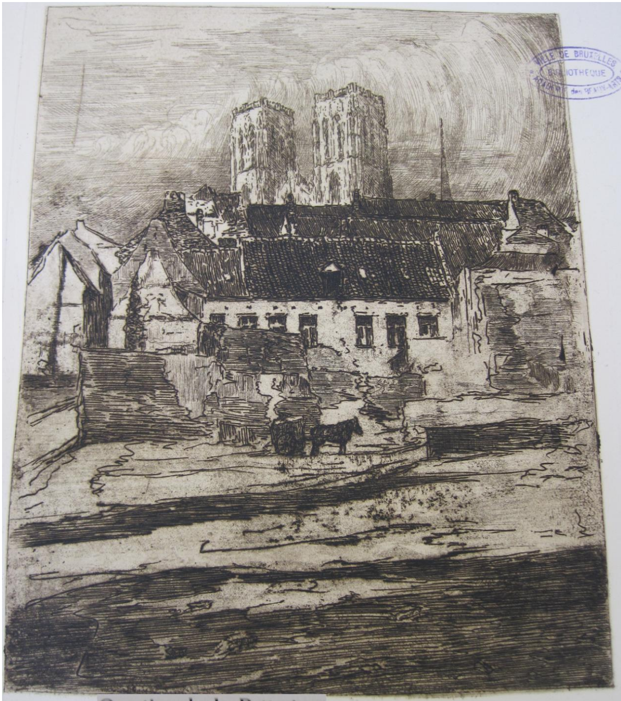
Quartier de la Putterie : 2. LES DÉMOLITIONS.
