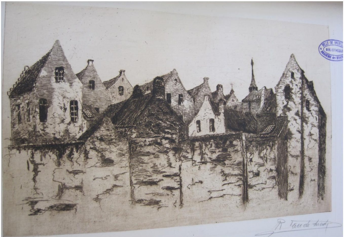
Quartier de la Putterie : 4. SÉRIE D'ARRIÈRE-PIGNONS (Rue de la Montagne et rue du Singe).
